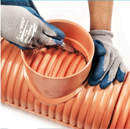
Coloque la silla tee sobre la tubería, trace el contorno del hueco y el contorno de la silla tee. Utilice preferiblemente un marcador.
