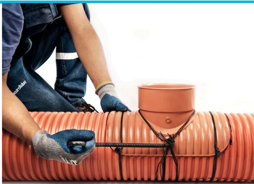
Antes que fragüe la soldadura y con alambre de negro N° 16 de 4 hebras presione firmemente con la ayuda de un martillo. Un tercer alambre será necesario colocar para garantizar la hermeticidad.
