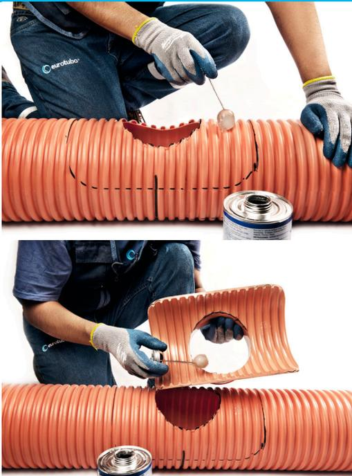
Con la ayuda de un hisopo, aplique cemento disolvente (pegamento) hasta cubrir las crestas de las corrugas. De igual manera realice la operación aplicando soldadura en la silla tee de base corrugada.
