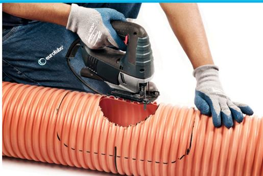
Perfore la tubería utilizando una sierra de copa de 6" o caladora. La otra opción de perforar la tubería es, empleando un serrucho de punta. Cuando realice cortes, nunca golpee la superficie interior del tubo con la punta del serrucho.
