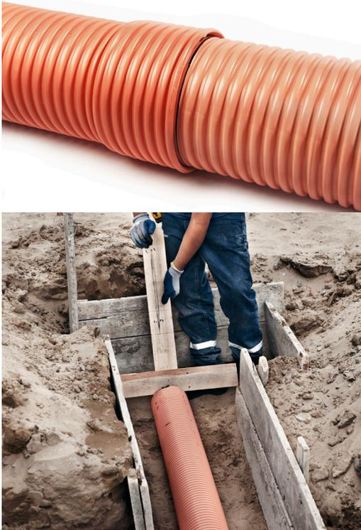
Empalmar introduciendo hasta el fondo de la campana (hasta el marcado) manualmente o con ayuda de una barreta haciendo palanca; pero protegiendo el extremo del tubo con una madera.
